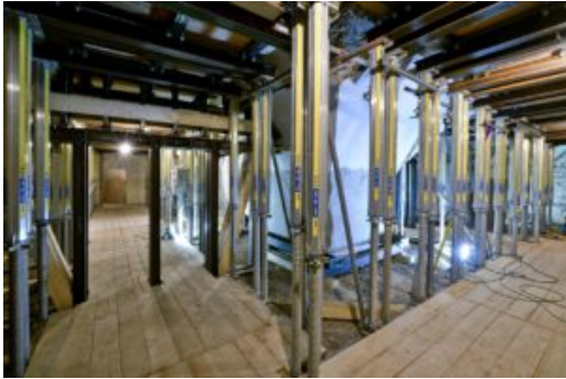
Abb.: Gotha, Schloss Friedenstein, Stahlkonstruktion zur Sicherung desolater Stützpfiler im Kellergeschoss, Lutz Ebhardt
